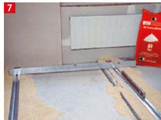
7 Vom hinteren Ende des Raumes zur Tür hin über die Auflegeleihen die Trockenschüttung abziehen. Vor dem Abziehen kann die Trockenschüttung bereits leicht verdichtet werden. Installationsleitungen sollten mit mind. 12 mm überdeckt werden (dreifaches Größtkorn).
